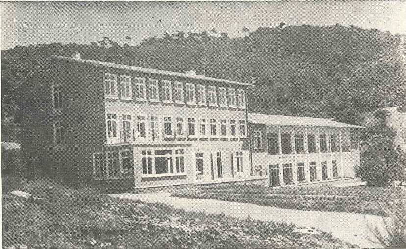
Şekil: 154 — Heybeliada sanatoryumu rehabilitasyon merkezi binası.
