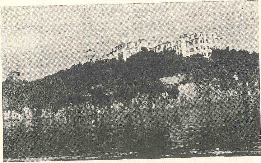
Sekil: 110 — (A) blokunun umumi görünüşü.
