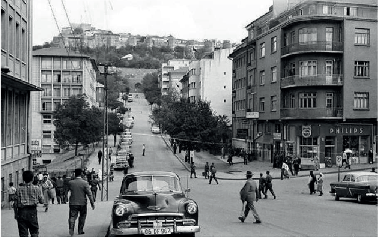
■ Sağda Ali Nazmi Apartmanı ve alt katında Philips bayi (Yavuz İşçen arşivi)
