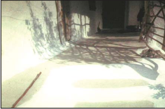
Sayfa 50 Resim 10: Beyaz toprağın bulamaç haline getirildikten sonra oda zeminine sürülmesi.
