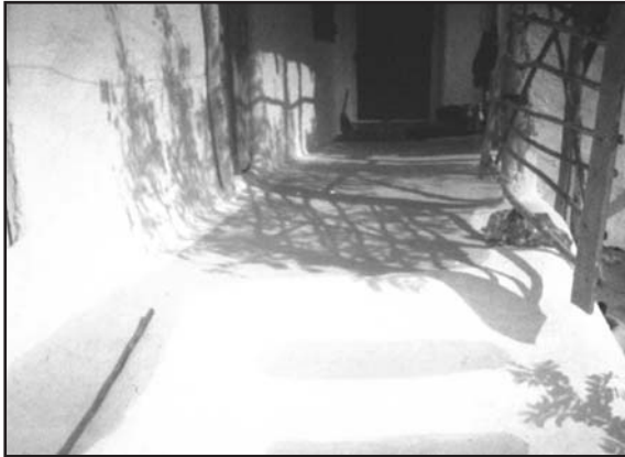
Resim 10: Beyaz toprağın bulamaç haline getirildikten sonra oda zeminine sürülmesi.
