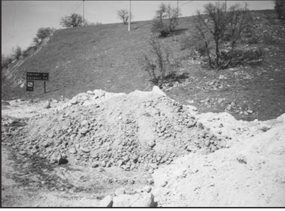
Resim 12. Yollara serilmek için hazırlanmış içinde asbest bulunan kurşuni - gri renkte toprak yığını.
