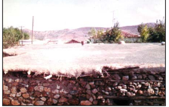
Sayfa 50 Resim 9: İçinde asbest bulunan toprağın izolasyon, sıcak ve soğuktan korunmak için çatıya serilmesi.
